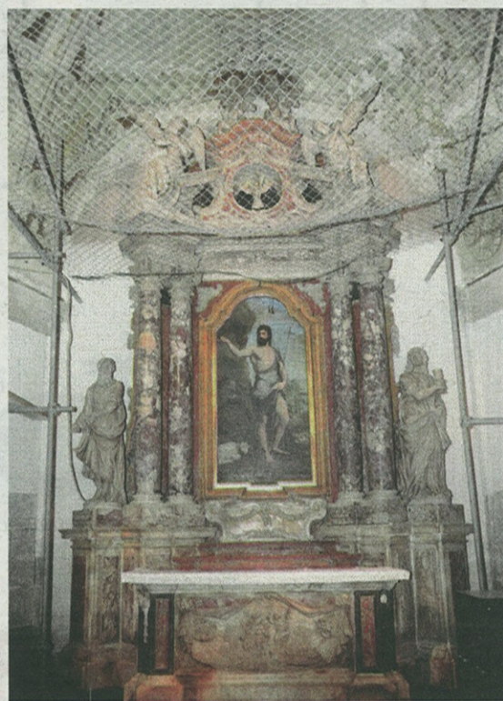
All'interno della chiesa i lavori di restauro sono ancora in corso
